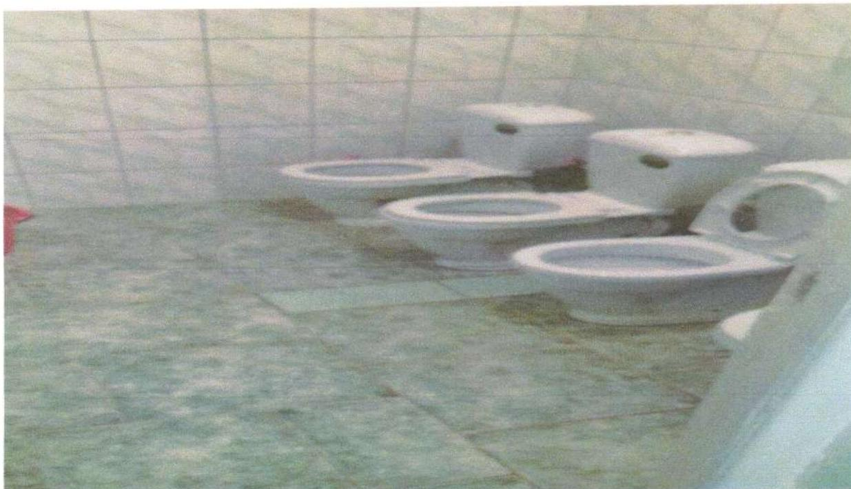
Существующая санитарная комната имеет ненормативные размеры в плане. Она не соответствует требованиям п.5.3 СП 59.13330.2012. Но в связи с тем, что конструкции здания невозможно изменять по техническо-конструктивным требованиям, предлагается до реконструкции использовать туалет только для МГН категорий «Г» и «С». Следовательно, использовать ее для инвалидов категории «К» и «О» невозможно.
